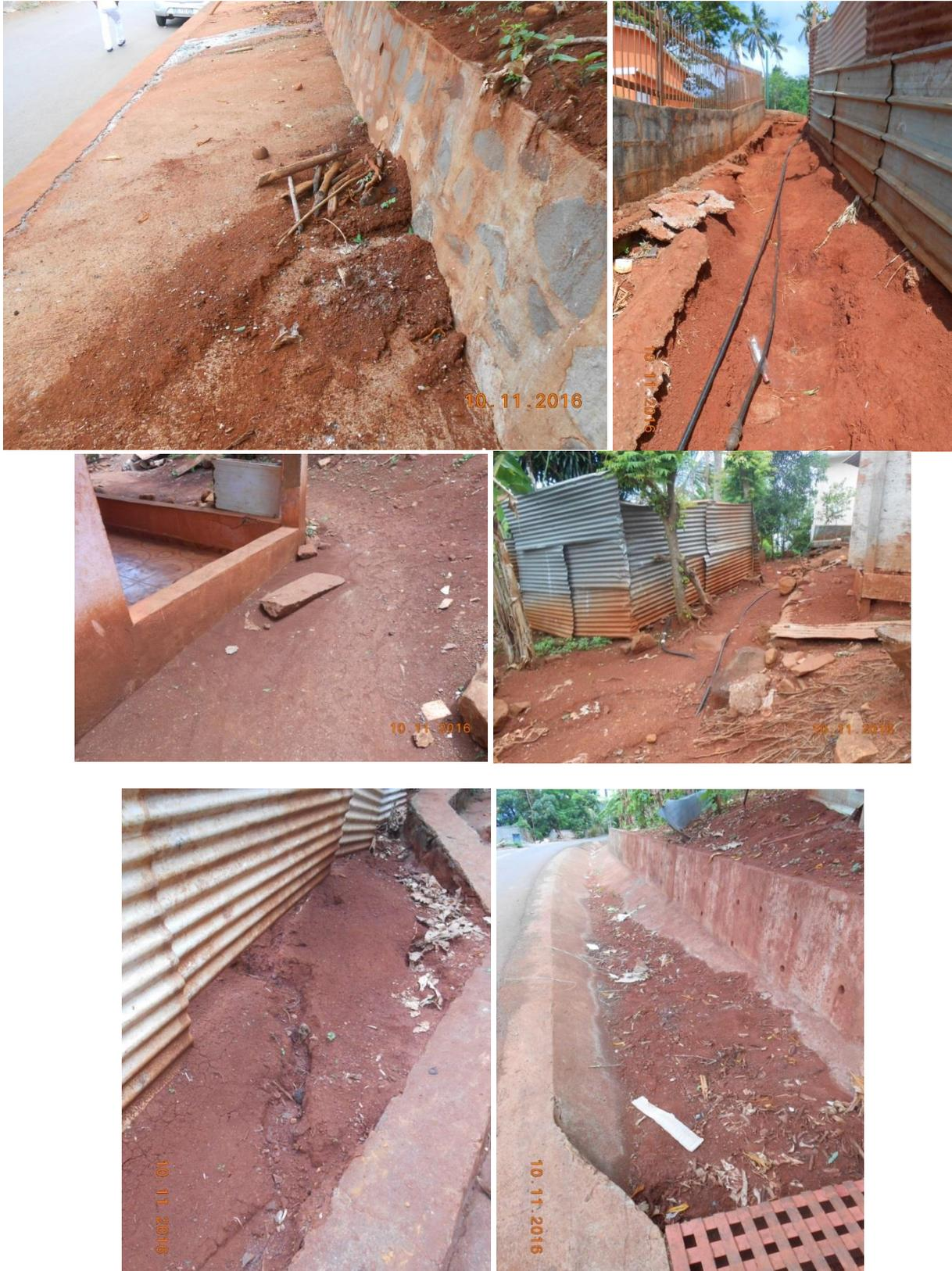
Illustration 22 : Ravinement localisé avec concentration des écoulements
